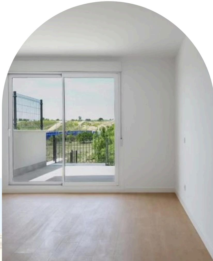
Carpintería corredera con rotura de puente térmico y adaptativa a las construcciones más exigentes, dada su versatilidad para ser instalada sobre cercos de 2 carriles con 65 ó 75 mm de profundidad.
